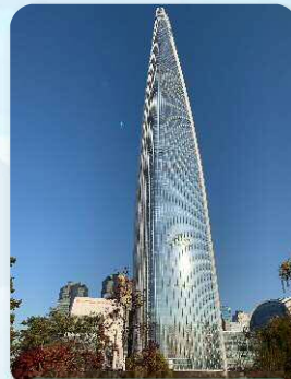
ロッテタワー
