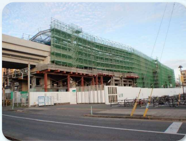
現在高架工事進行中の白木原駅風景
