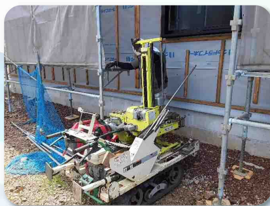
建築途中での地盤調査
