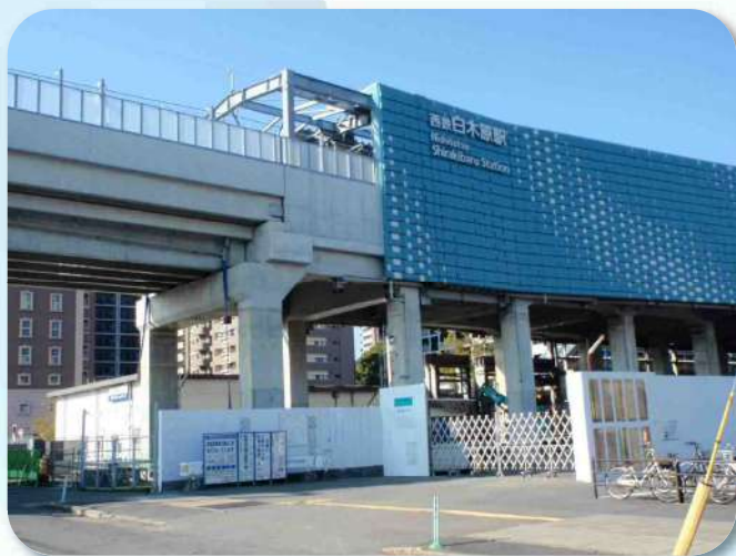
2022年8月高架運転開始した 白木原駅の現在の状況
