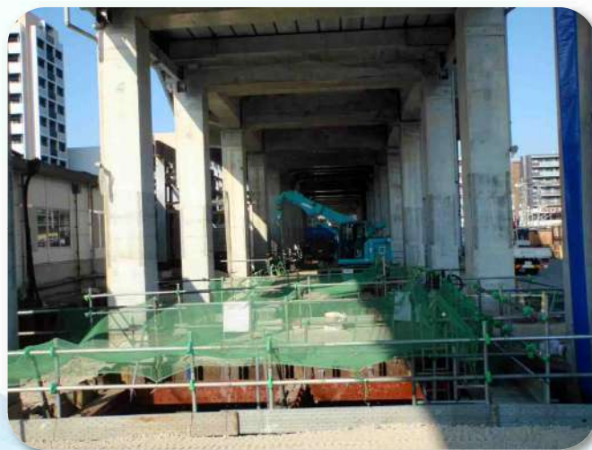
開通後も高架下は残工事が進んでいる
